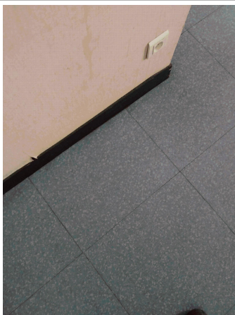
Prélèvement - P001 : RDC / LOCAL S 0.07 PASTEL - Lé plastique avec sous-couche- (Absence d'amiante)
